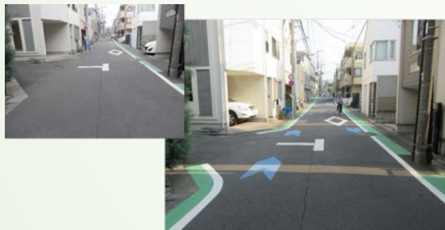
片側から両側への路側帯設置
