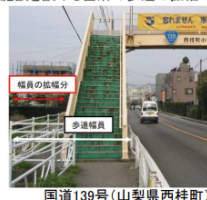
国道139号（山梨県西桂町）
