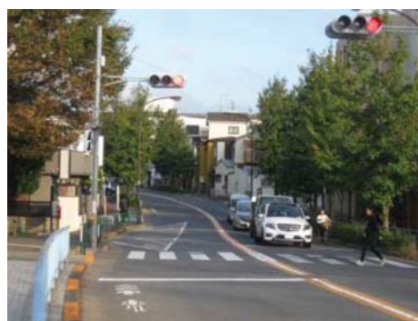
▼区内の緊急輸送道路の例（五日市街道）
