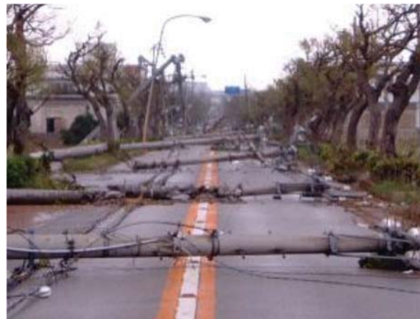
▼電柱の倒壊事例
