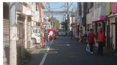
▼現状は幅員が狭く燃えやすい建物が多い（高円寺北）
