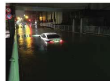
八高線アンダーパス（八王子市）
