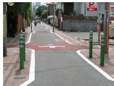
狭さくにより車の速度を抑制している事例(吉祥寺)
