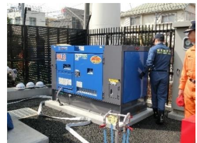
新設広場に深井戸を整備した事例 (阿佐谷南・高円寺南地区)
