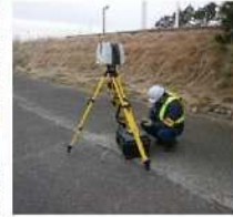
3D点群データ計測調査 地上計測
