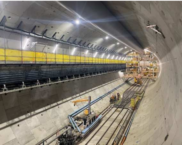
本線南行坑内（2825R 付近） （切羽側から坑口側を望む）
