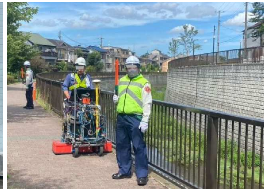
調査実施状況（歩道部）
