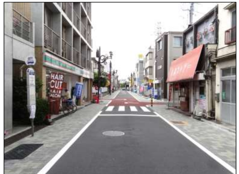
無電柱化整備後
