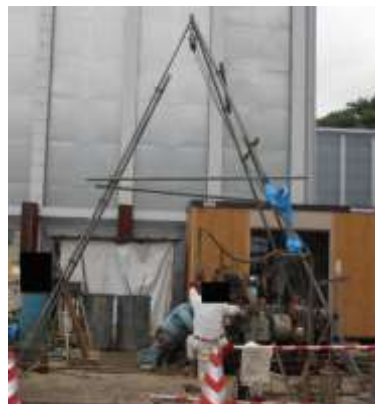
ボーリング調査
