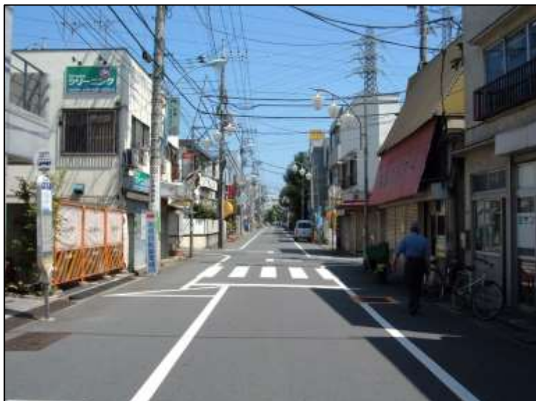
無電柱化整備前
