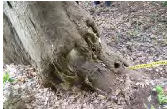
(4)太根に空洞が発生している例
