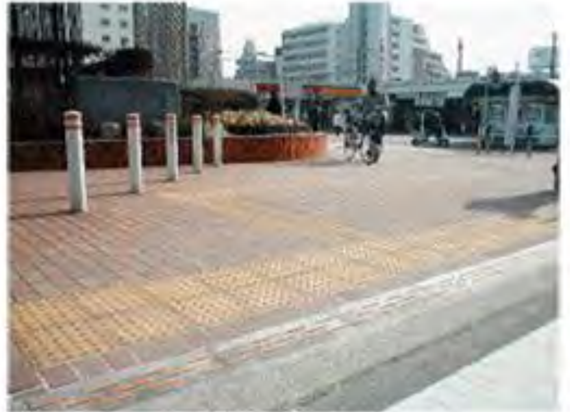
写真 2-1-3 縁端高さ 0cm から背面高さ 2cm 構造の歩車道境界
