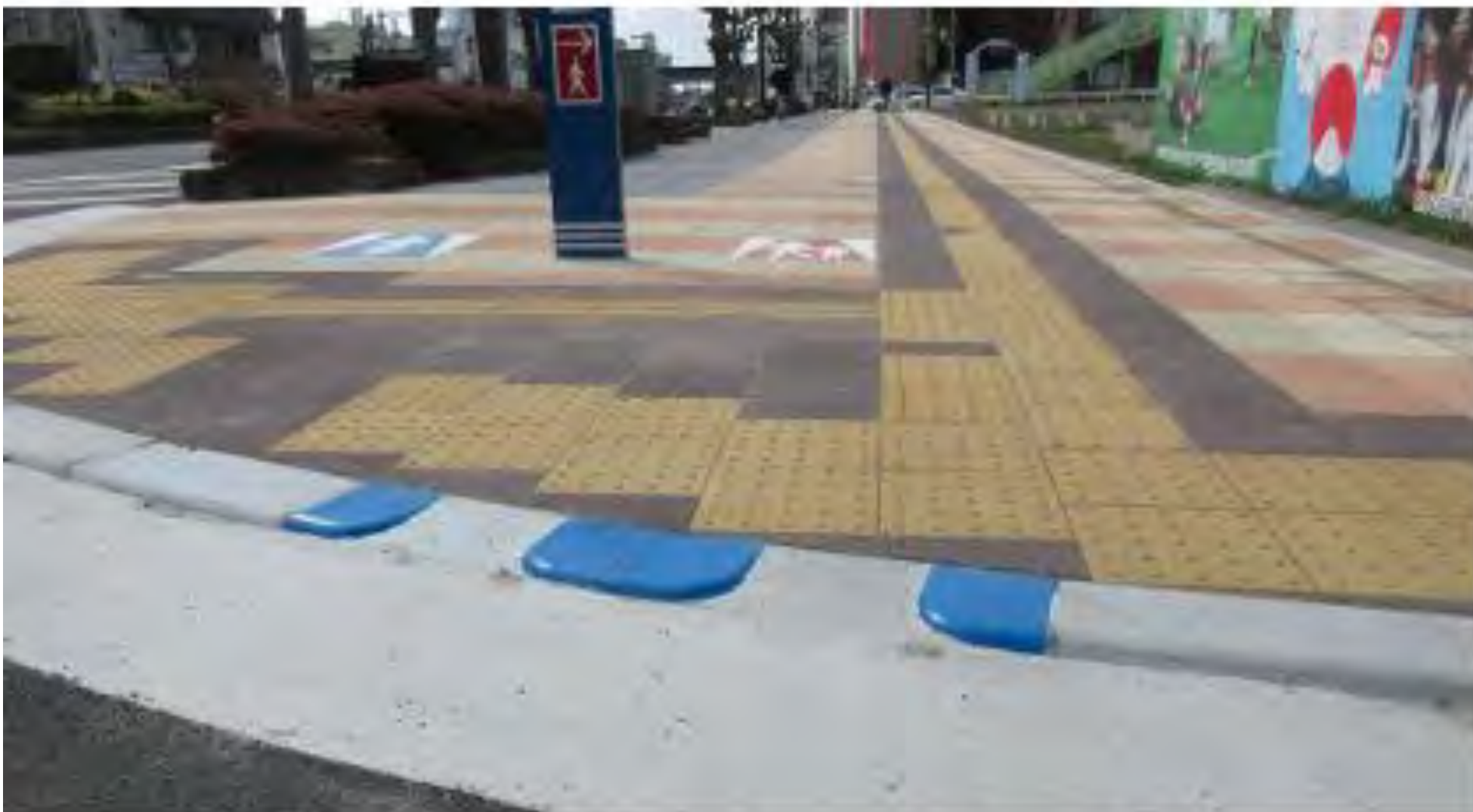
写真 2-1-1 縁端高さ一部 0cm 構造の歩車道境界
