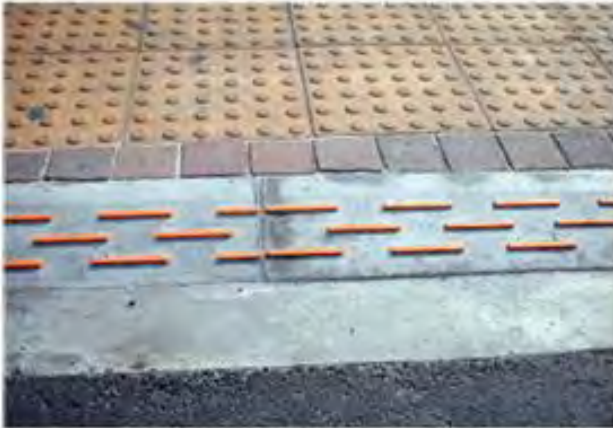
写真 2-1-3 縁端高さ 0cm から背面高さ 2cm 構造の歩車道境界
