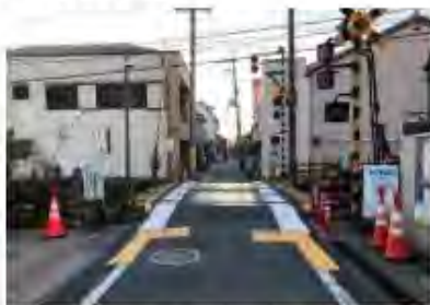
奈良県大和郡山市の事例 (歩車分離されていない道路での誘導用ブロック等の設置事例)
