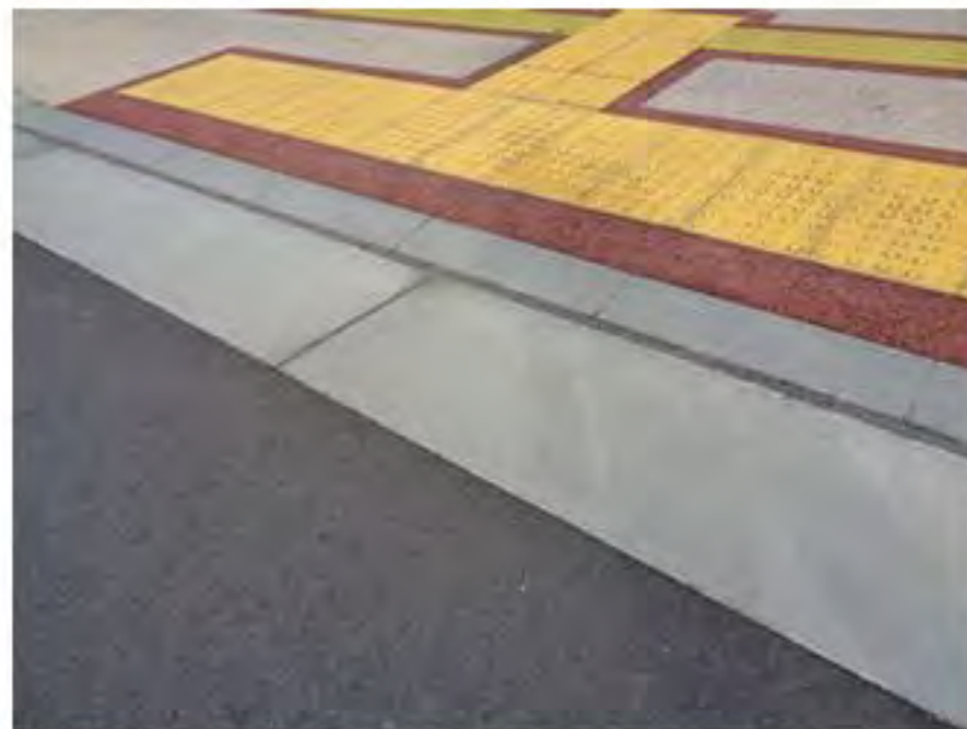
写真 2-1-7 縁端高さ 1cm から背面高さ 3cm 構造の歩車道境界
