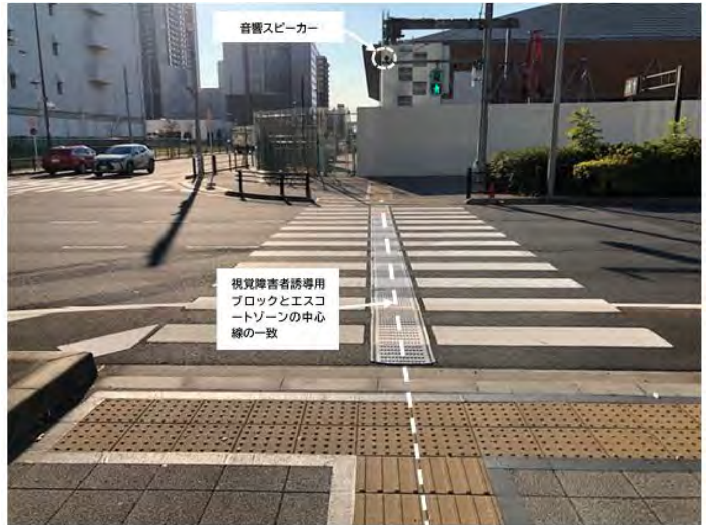
写真 1-2-1 視覚障害者誘導用ブロックとエスコートゾーン、音響スピーカーの位置を一致させている事例
