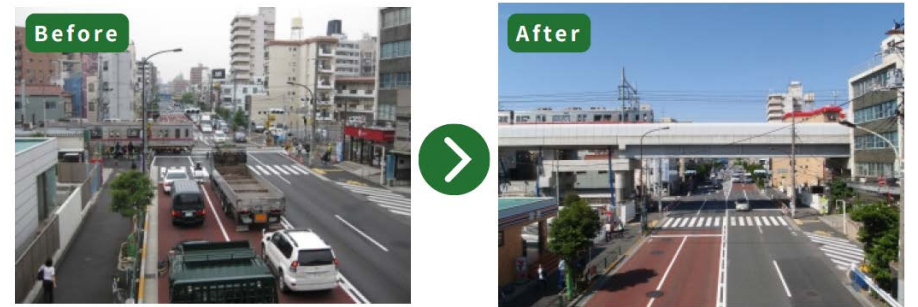
京成押上線（京成曳舟駅付近）明治通り 線路を高架化や地下化することで、踏切を除却します
