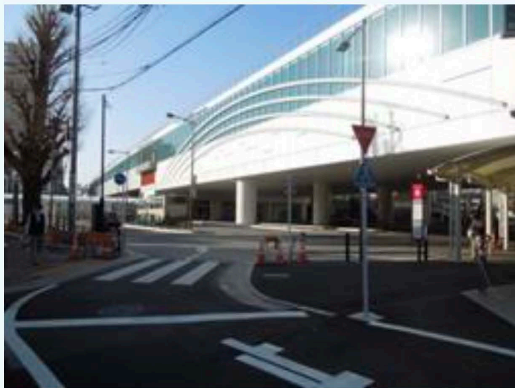
高架下駅前広場の現状（石神井公園駅）
