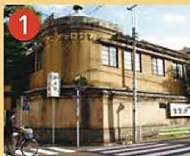
1 杉並「まち」デザイン賞 西郊ロッチング 昭和初期に随い付き高級下宿として建てられた建物です。国の登録有形文化財です。
