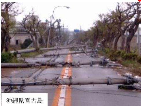
台風で倒壊した電柱による道路閉塞 ↓
