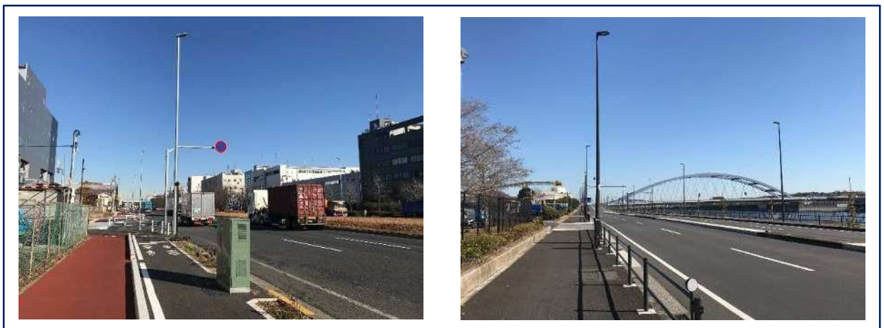
図IV-7 臨港道路の無電柱化状況（新木場地区、海の森地区）
