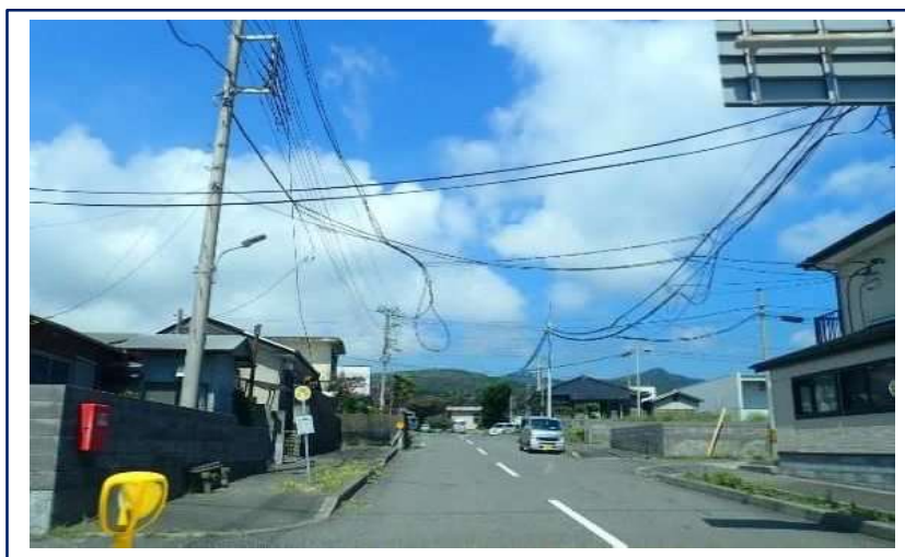
図IV-8 大島クダッチ地区の被害状況（令和元年9月）
