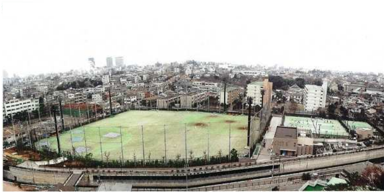
图 2-8 上高田調節池 全景
