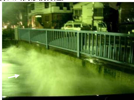
平成17年9月妙正寺川天神橋
