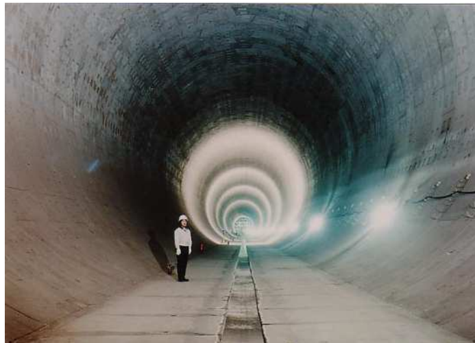
图2-4 神田川・環状七号線地下調節池
