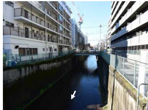
妙正寺川落合橋付近
