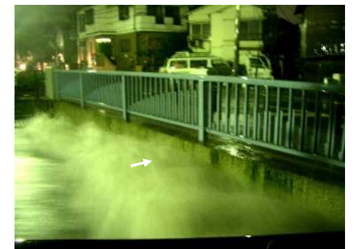
平成17年9月妙正寺川天神橋
