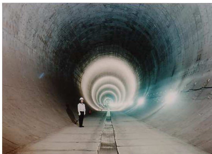
図2-4 神田川・環状七号線地下調節池
