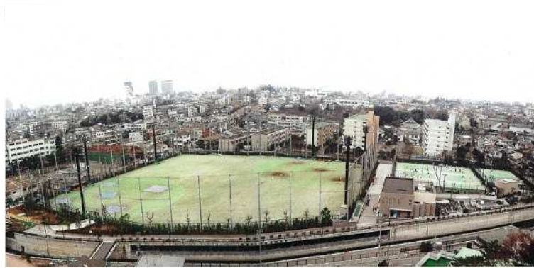
図 2-8 上高田調節池 全景
