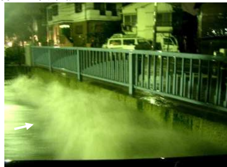
平成17年9月妙正寺川天神橋
