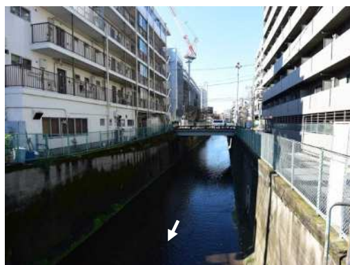
妙正寺川落合橋付近
