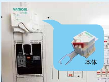
地震の際、バネの強い力により確実にブレーカーを遮断。地震による停電からの復帰時、通電火災を防止します。高さ・長さの調節ができ、レバー埋込型・扉付きタイプのブレーカーにも取付け可能です。震度5強以上と震度6弱以上の切り替えあり。
