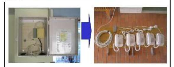
電話端子盤内の回線端子と延長ケーブル側の電話 コードを接続して下さい
