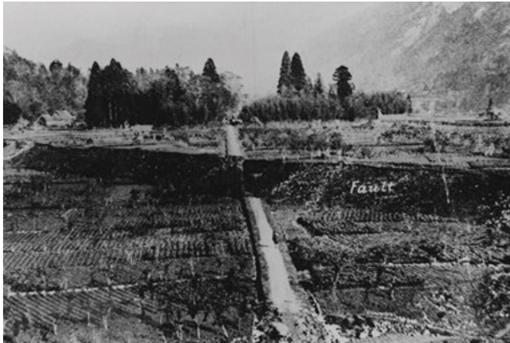
断層のずれにより、写真中央の道路が寸断している（当時撮影）（本巣市）写真撮影：小藤文次郎氏
