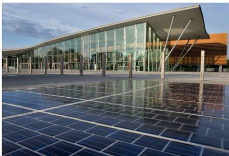
駐車場（EV 充電）（フランスの事例）
