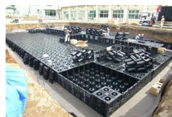
校庭下に設置する浸透・貯留槽
