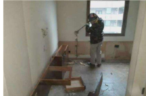
内装解体(参考写真)
