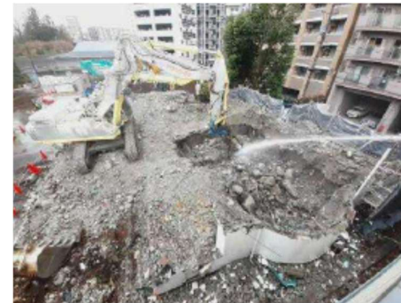
重機基礎解体(参考写真)
