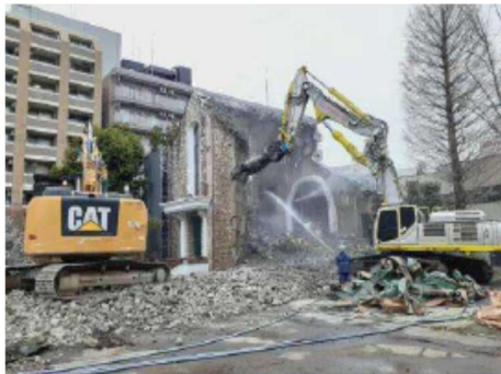
重機上屋解体(参考写真)
