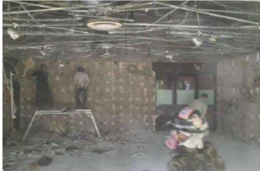
内装解体(参考写真)
