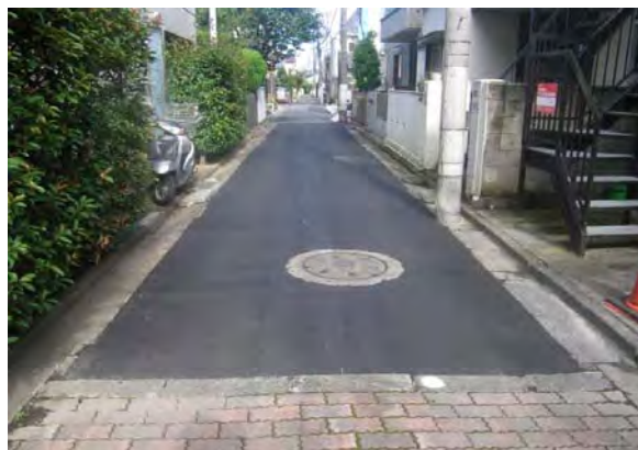
道路維持補修工事（施行後）
