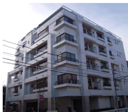
フレーム補強の事例
