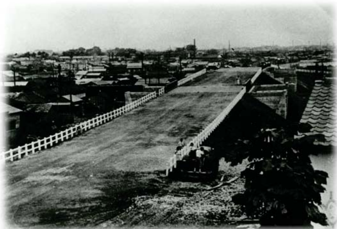
昭和26年 荻窪陸橋工事中(阿佐谷方面から)
