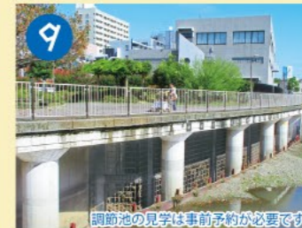
神田川・環状七号線地下調節池の取水口 神田川中流域の洪水対策として、環七通りの地下約50mに約54万㎡の洪水を貯留できる調節池がつけられています。
