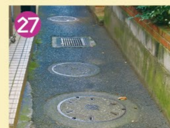
多数のマンホールのある水路跡歩道 この付近には水路を暗渠にした狭い歩道が続いており、非常に多くのマンホールの蓋が並んでいます。
