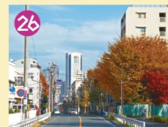
玉川上水新水路跡(水道道路) 旧玉川上水に替えて、代田橋から旧淀橋浄水場まで新水路を構築しましたが、地震で破損したため廃止して道路となりました。
