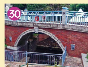
ゆずり橋 稲田石とレンガタイルで飾られた歩行者専用橋で、子ども達のアイデアやデザインが多く採り入れられています。平成3年完成。
