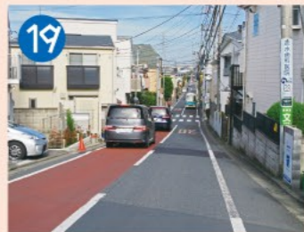
19 荒玉水道道路 世田谷区砧と杉並区妙法寺脇を結ぶ直線道路で、荒川と多摩川(玉川)を結ぶ計画であった水道管が地下に埋まっています。
