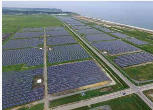
海沿いに整備されたソーラーパネル
