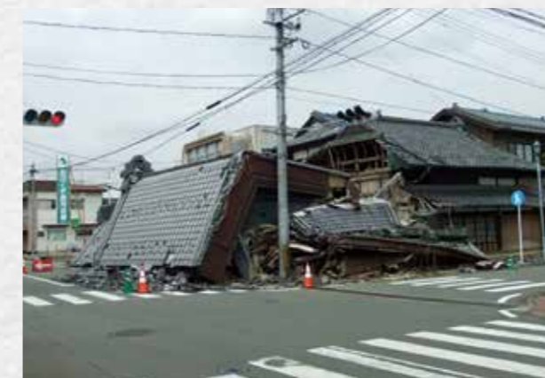
地震により崩壊した家屋
