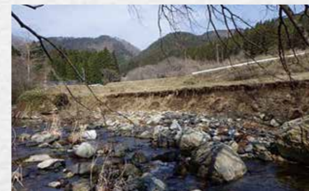
災害復旧工事着手前(上真野川)
