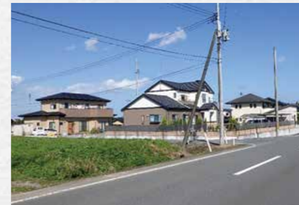
造成された鹿島区(寺内地区)の宅地(全48戸)
