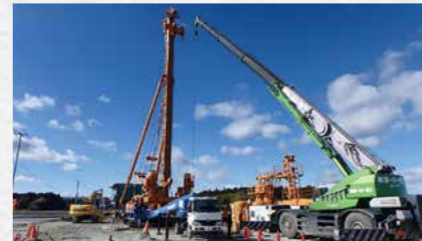
災害復旧工事の現場の様子
