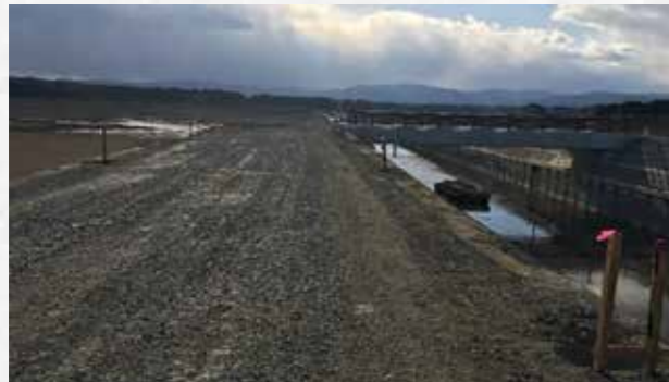
災害復旧工事の状況(井田川地区)
