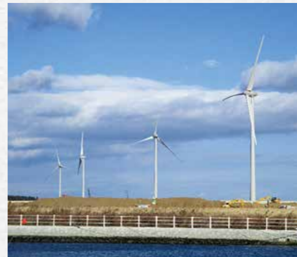
海沿いに整備された風力発電
