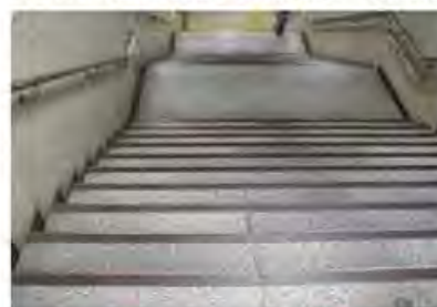
参考 2-1-21：踏面端部（段鼻部）の識別しやすい例
