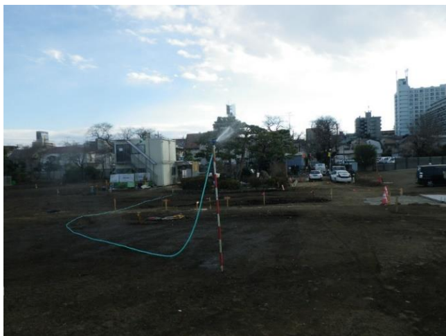
スプリンクラーによる散水状況
