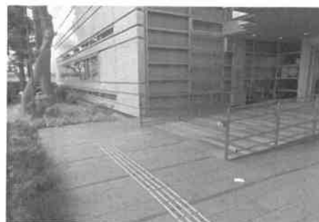
スロープ設置例 (中央図書館)
