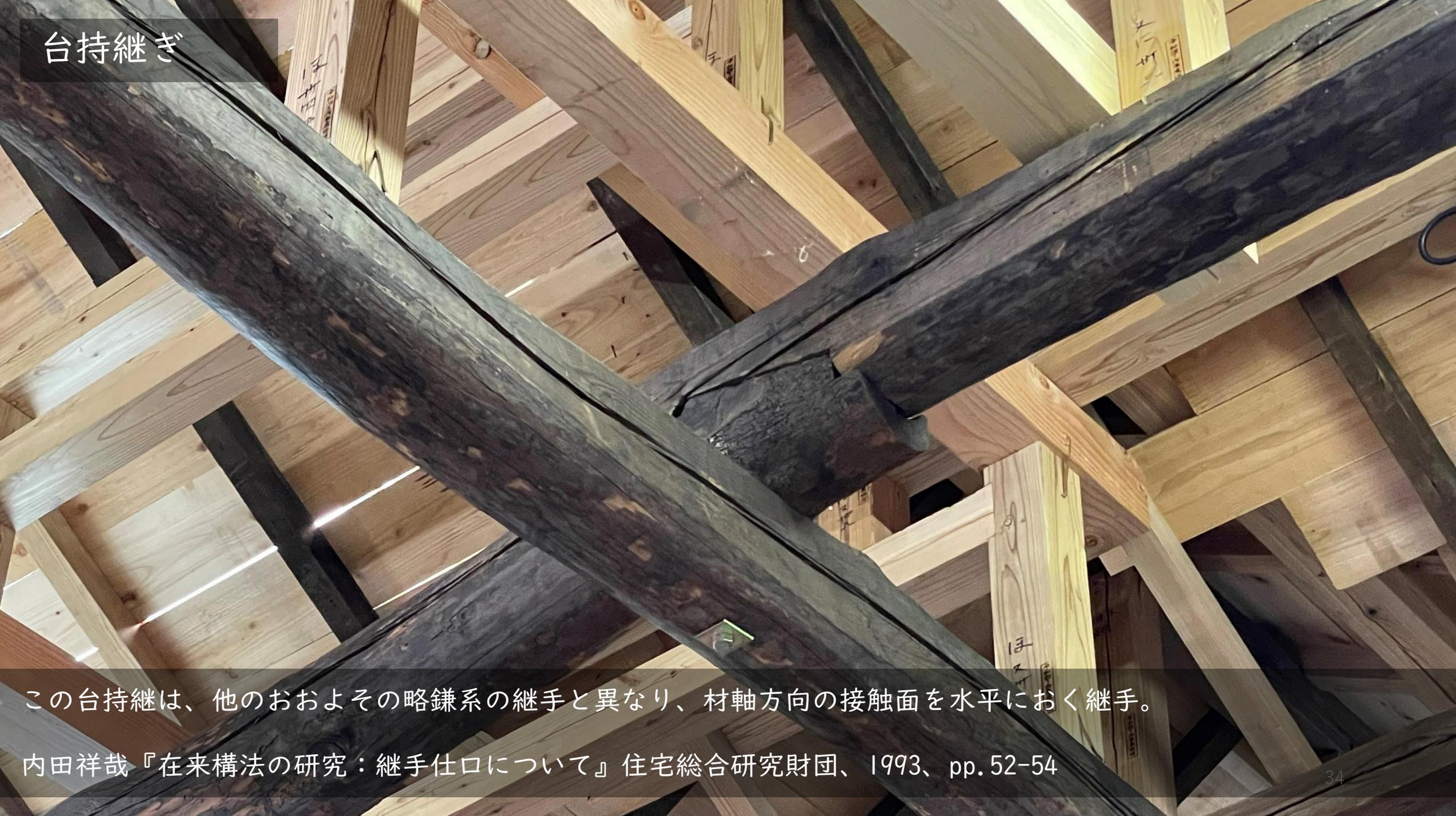
この台持継ぎは、他のおおよその略鎌系の継手と異なり、材軸方向の接触面を水平におく継手。
