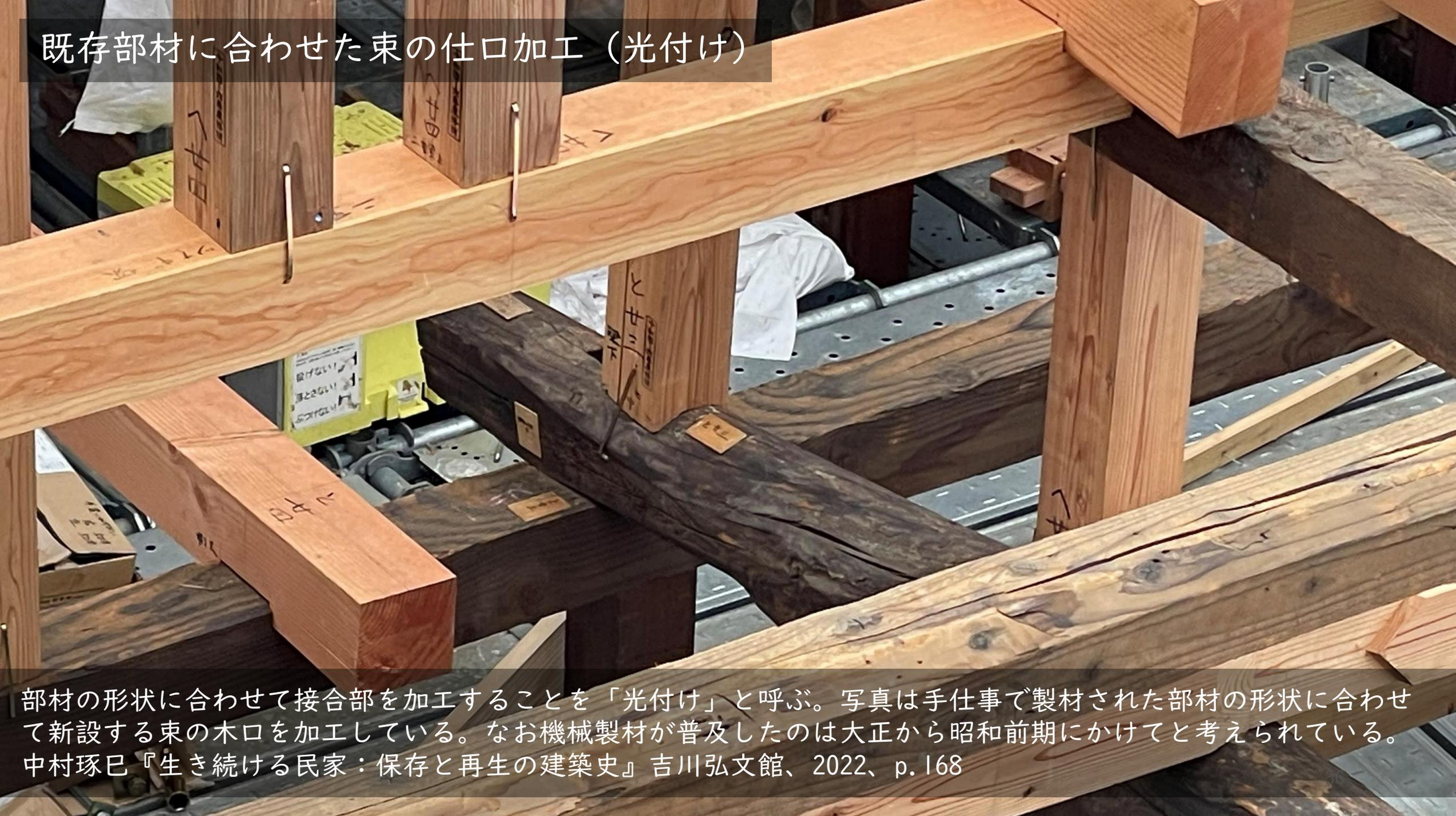
部材の形状に合わせて接合部を加工することを「光付け」と呼ぶ。写真は手仕事で製材された部材の形状に合わせて新設する束の木口を加工している。なお機械製材が普及したのは大正から昭和前期にかけてと考えられている。
