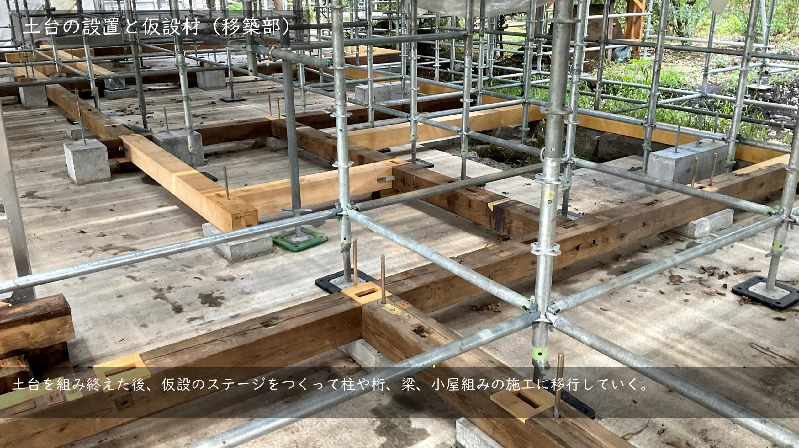
土台を組み終えた後、仮設のステージをつかって柱や桁、梁、小屋組みの施工に移行していく。
