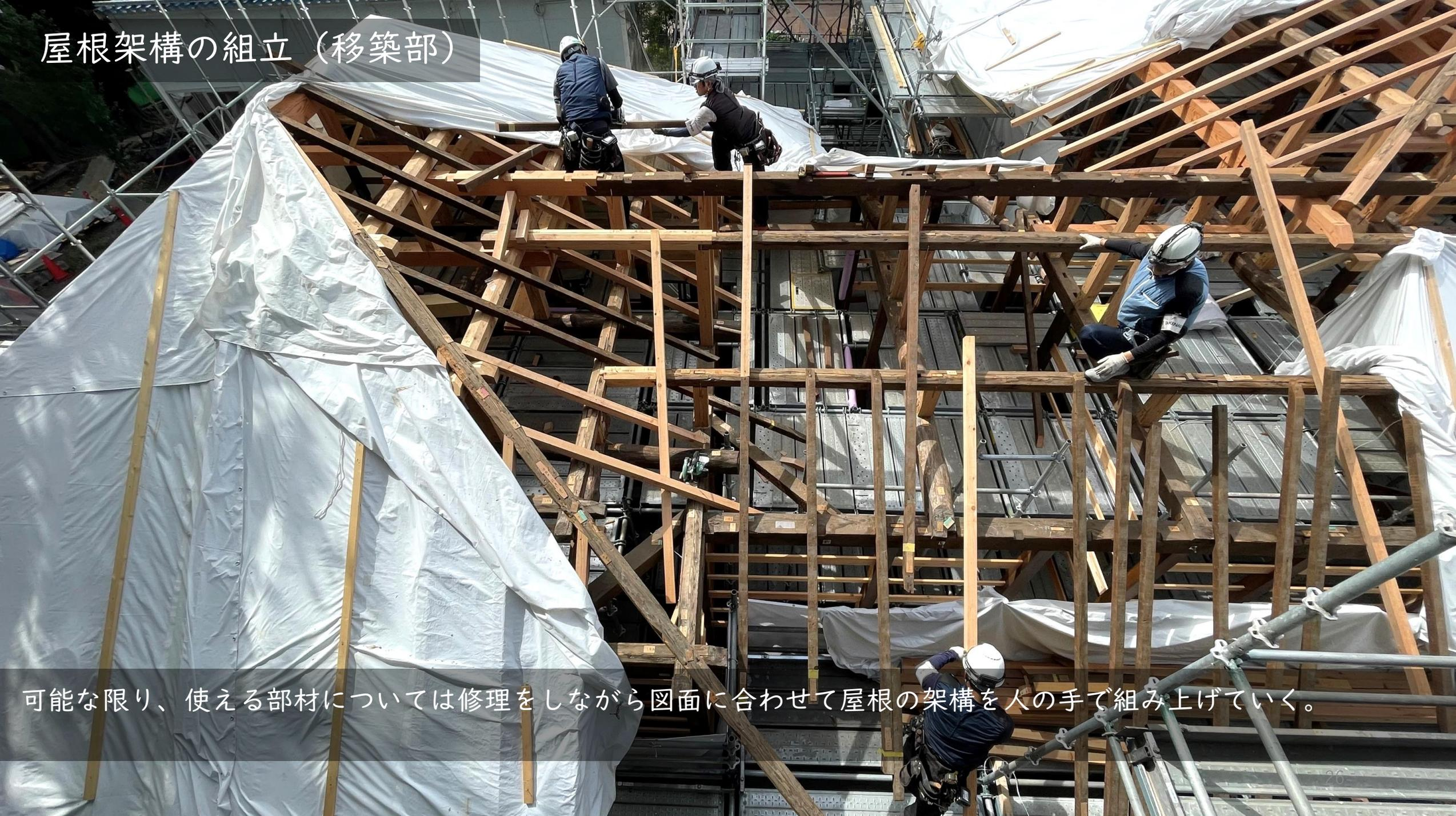
可能な限り、使える部材については修理をしながら図面に合わせて屋根の架構を人の手で組み上げていく。
