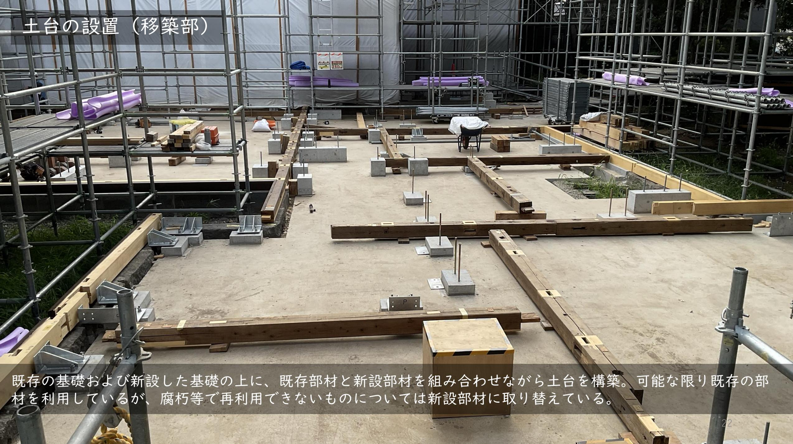
既存の基礎および新設した基礎の上に、既存部材と新設部材を組み合わせながら土台を構築。可能な限り既存の部材を利用しているが、腐朽等で再利用できないものについては新設部材に取り替えている。
