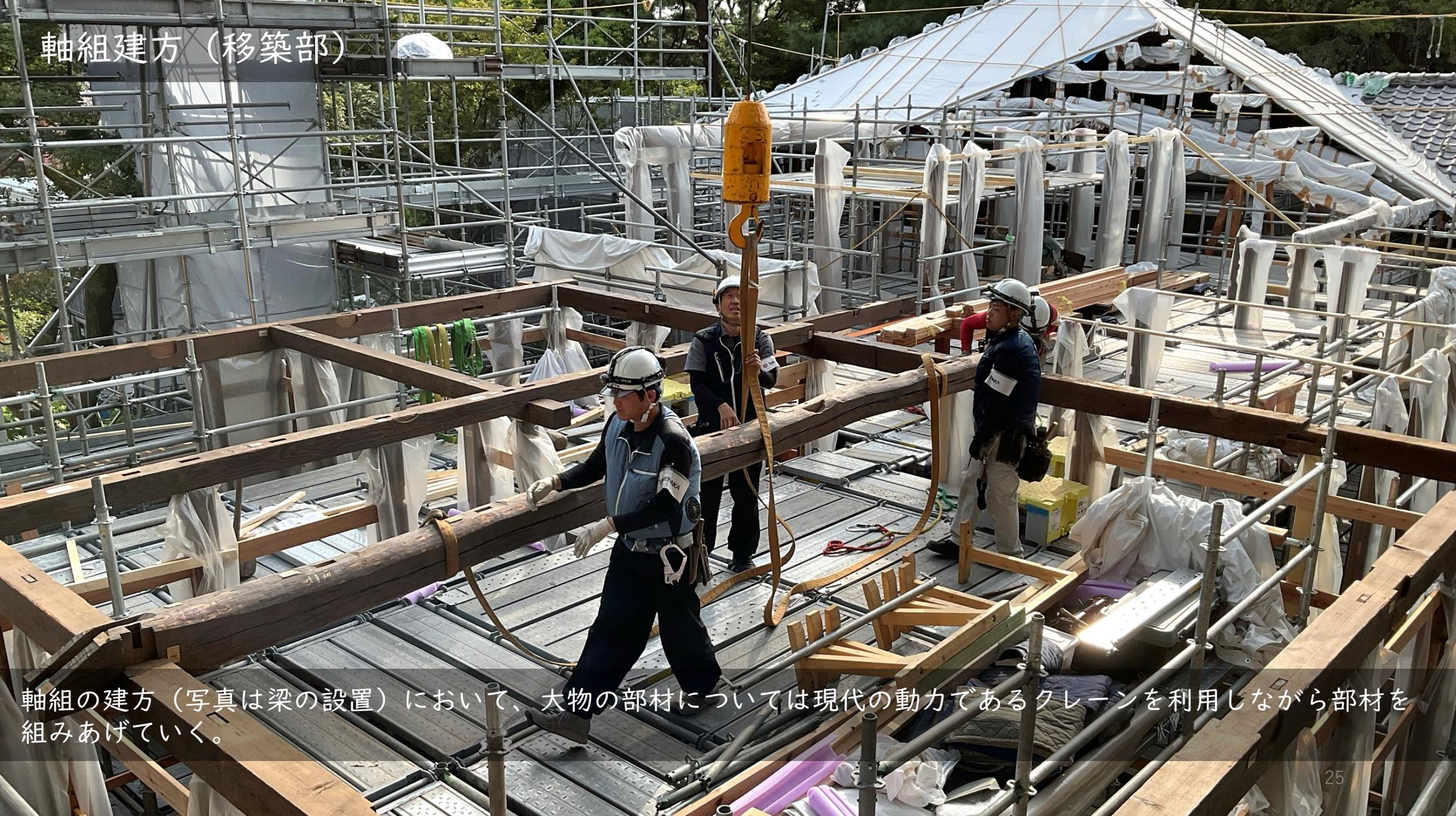
軸組の建方（写真は梁の設置）において、大物の部材については現代の動力であるクレーンを利用して部材を組みあげていく。
