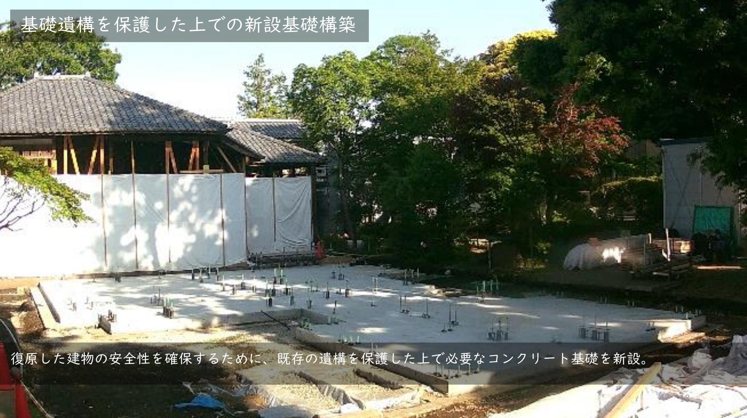
復原した建物の安全性を確保するために、既存の遺構を保護した上で必要なコンクリート基礎を新設。
