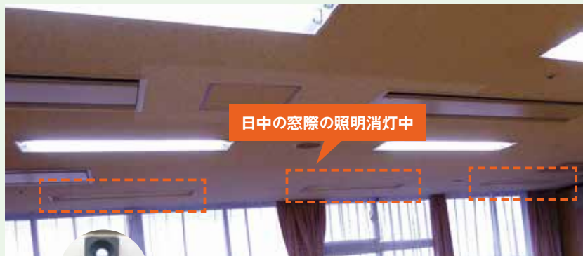
日中の窓際は、全ての照明を消灯しても656lxの照度がある。
