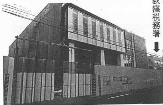
公務員住宅跡地に4月開設に向けて進む工事
