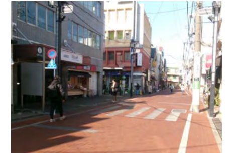
※4 カラー舗装改修工事
