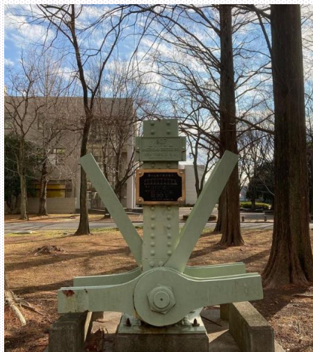
埼玉大学構内・第一大堰川橋梁格点
