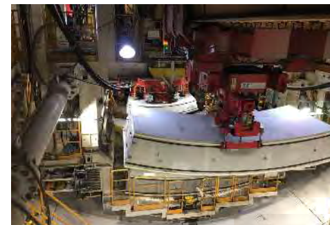
セグメント組立状況 (令和6年4月11日)
