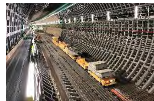
セグメント搬送状況 (令和6年3月16日)
