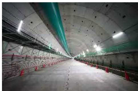
床版構築状況 (令和5年11月21日)
