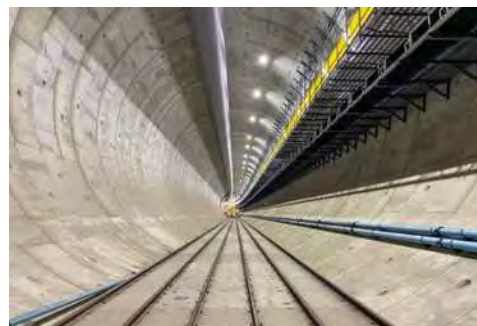
構築されたトンネル内(RCセグメント) (令和6年3月26日)
