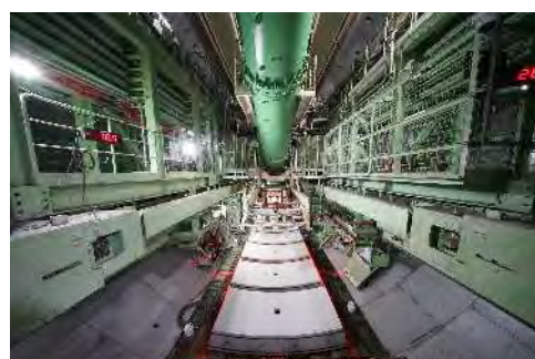
セグメント組立状況 (令和6年3月5日)
