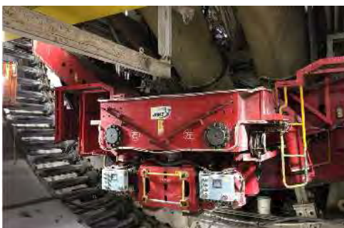
シールドマシンによる掘進状況 (令和6年4月11日)
