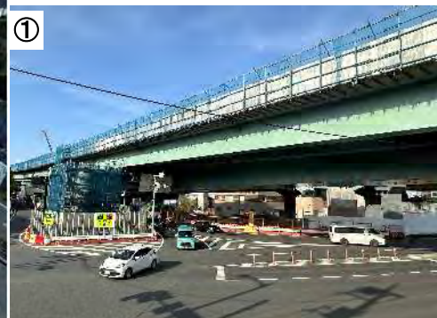
送出し架設後 (令和6年4月)
