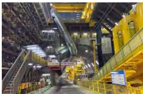
発進立坑部の状況 (令和6年3月26日)
