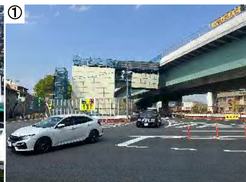
送出し架設前 (令和5年4月)
