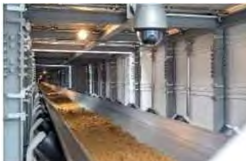
掘削した土砂をベルトコンベアで搬送する状況 (令和元年9月18日)
