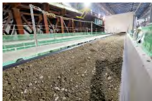
掘削した土砂をベルトコンベアで搬送する状況 (令和5年12月21日)
