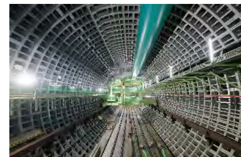
構築されたトンネル内(鋼製セグメント) (令和5年12月13日)
