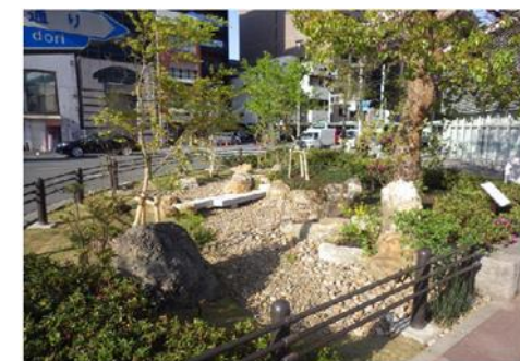
「グリーンインフラ(雨庭)」活用事例 四条堀川交差点（京都市） （出典：京都市ホームページ）
