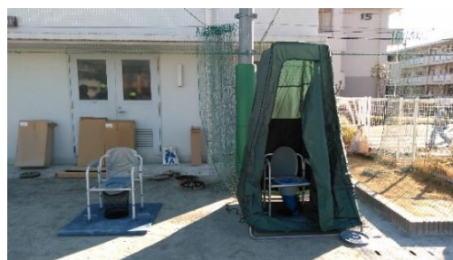
マンホールトイレ設置
