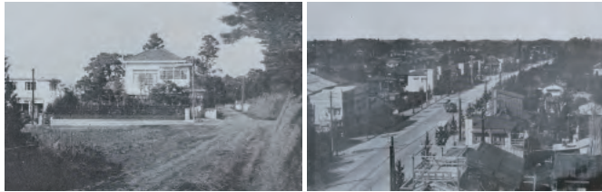
左:区画整理直後の第一工区(現荻窪2丁目付近)(出典:『事業誌』) 右:井荻信用組合本店屋上より見た区画整理後の井荻町西部方面(出典:『内田秀五郎翁』)
