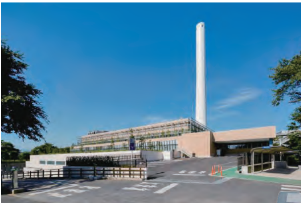
2017(平成29)年にリニューアルした工場 (写真：杉並清掃工場提供)
