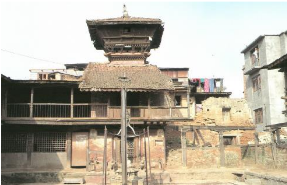
イ・バハ・バヒ僧院【修理工事前】
