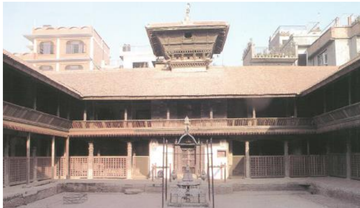
イ・バハ・バヒ僧院【修理工事後】
