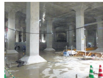
▲下高井戸調整池工事
