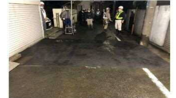
陥没箇所の応急復旧対応状況（舗装完了）
