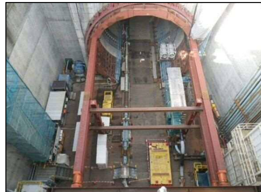
Aランプシールド立坑
