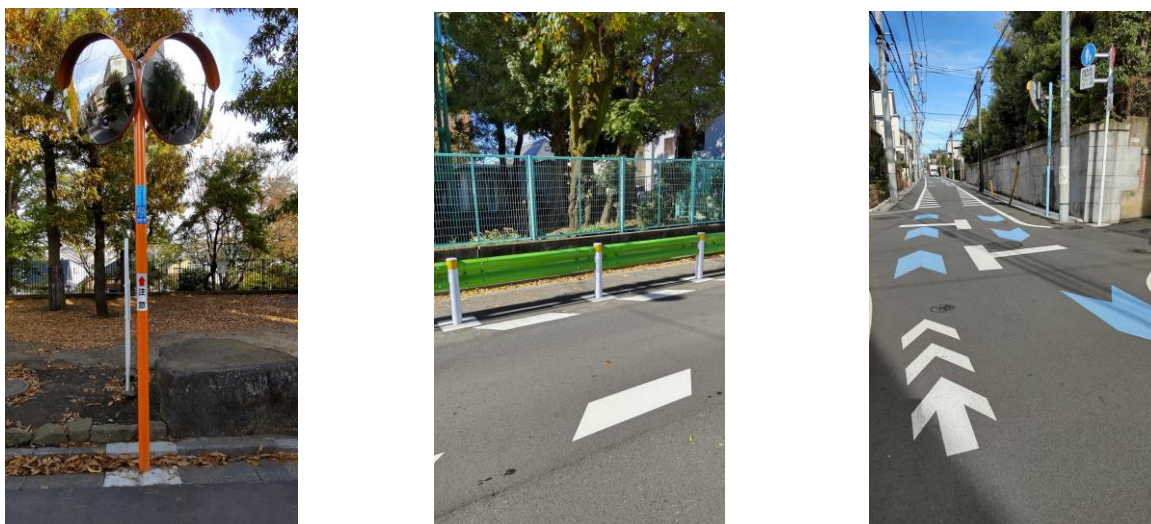
図表 2-19 交通安全施設（左：道路反射鏡、中：防護柵、右：自転車ナビライン）
