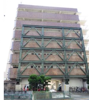
マンションの耐震改修事例
