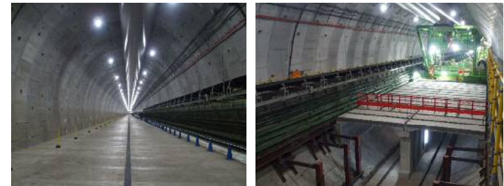
・大泉側 トンネル内状況(令和2年7月撮影)
