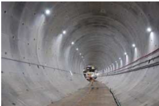
トンネル内部の写真(イメージ)
