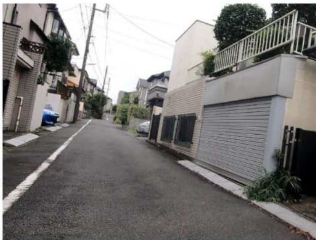
写真1 陥没箇所の事前状況写真(2020年7月30日)
