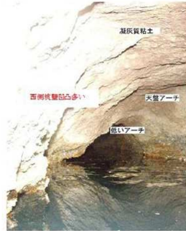
図1 0°方向の坑壁と北側の空洞
