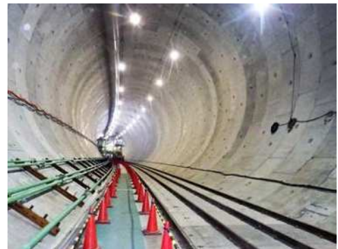
トンネル内部の写真(イメージ)
