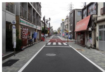
▲幅員8mの事例 (永福町駅北側)
