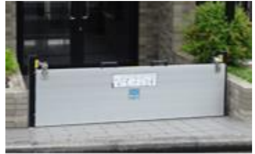
▲防水板の設置事例
