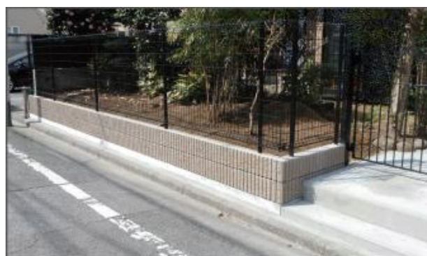
▲ブロック塀改修後
