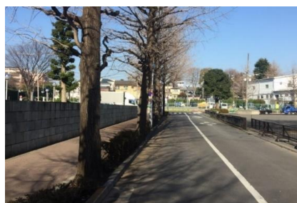
▲幅員9mの事例 (和田2丁目付近)
