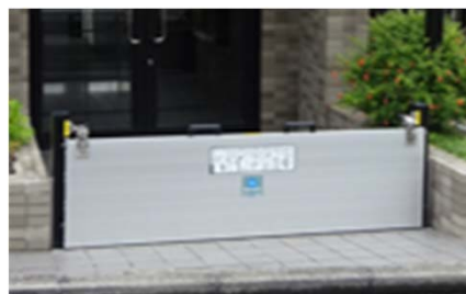
▲防水板の設置事例
